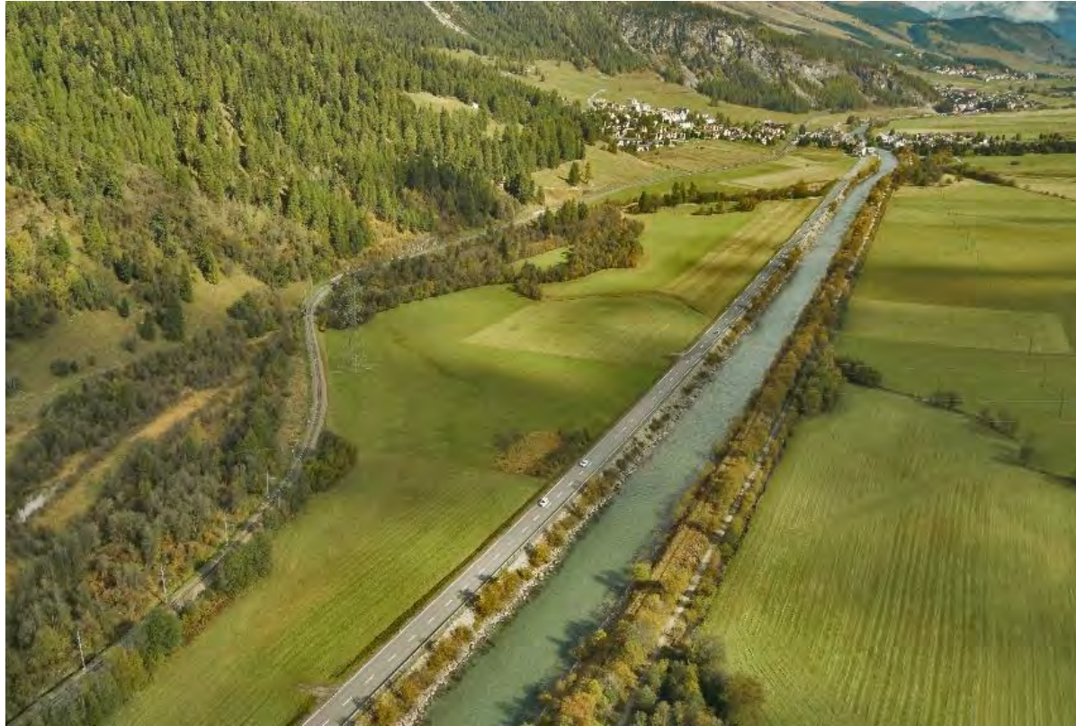
Ist-Zustand: Inn-Kanal, RhB und Kantonsstrasse zwischen Bever und La Punt
